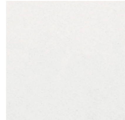
Paredes viviendas Placas de yeso tipo Pladur color blanco
