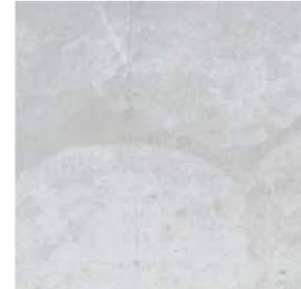
Techos viviendas C/ del Carme Forjado hormigón visto
