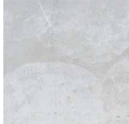
Escaleras y suelos zonas comunes Hormigón visto
